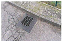
Entretien du réseau pluviale
