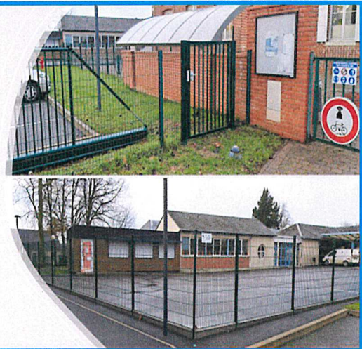
Remplacement de la clôture par des panneaux rigides doubles fil et création d'une entrée piétonne.
