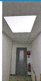
Travaux de rénovation dans les locaux de la Police municipale
